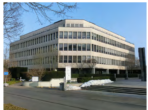
Data Center der Generali Personenversicherungen, Adliswil: Energiekonzept für die Nutzung der Abwärme
