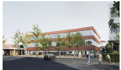
Bauherrenvertretung Neubau Schulhaus Sekundarschule Dübendorf-Schwerzenbach
