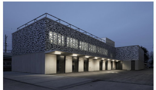
Generalplanung Versuchshalle Aquatikum Eawag, Dübendorf
